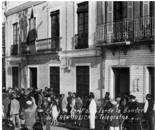
Izado de bandera republicana en la Central de Telégrafos. Archivo Sánchez Montoya.
