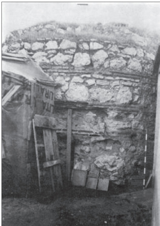
Torre de sillares y mampostería del recinto fortificado donde se albergaba la greda (imagen de 1982). Foto: Reyes Téllez et al, 1982.
