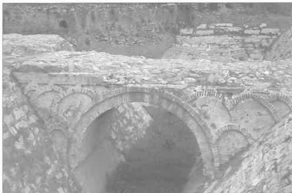
Lám. 14.- Prolongación de la Avda. Blas Infante. Puente que, salvando el foso, permitía el acceso hasta la Torre-Puerta de Gibraltar. Fachada sur.
