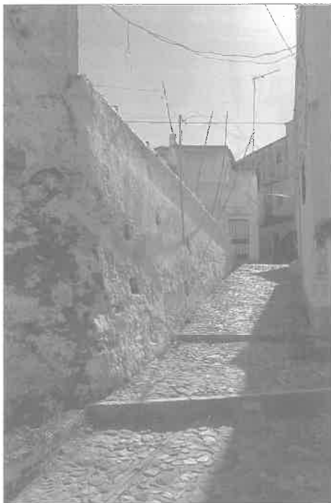
Lám. 4.- Villa Vieja. Rampa de acceso, en zig-zag, que perteneció a la conocida como Puerta del Mar.
