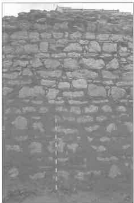
Lám. 10.- Prolongación de la Avda. Blas Infante. Escarpa del foso y arranque de la barrera o barbacana.
