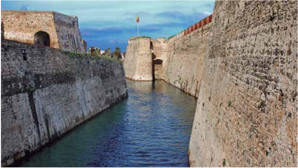
Fig. 5.- Fosso de “mar a mar” entre o baluarte de São Sebastião e de São Tiago em Ceuta.
