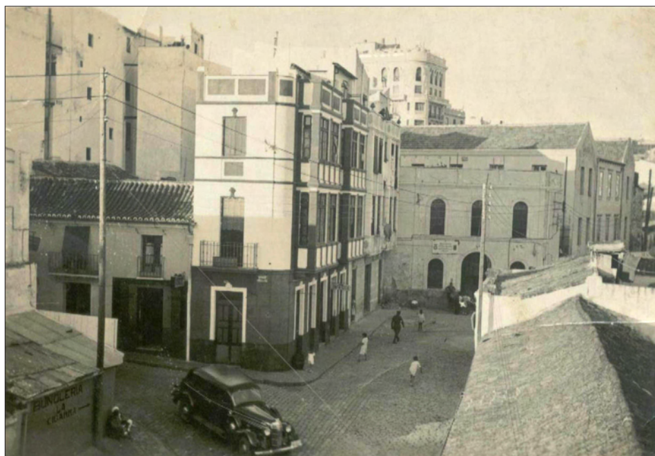
Edificio del Patronato Militar de Enseñanza en la calle Cervantes. Col. Clemente Cerdeira García de la Torre
