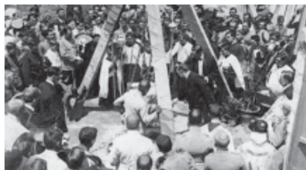
5 de agosto de 1914 colocación de la primera piedra, por parte del Alcalde Demetrio Guillén. (Foto: Archivo Central de Ceuta)
