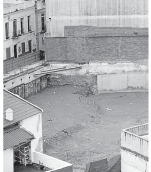
Primeros trabajos en el Pasaje Fernández.
