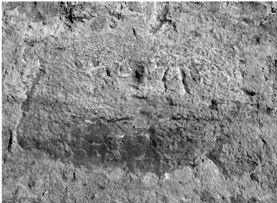
Lámina 2. Marca de cantero con forma de letra A (contraescarpa del foso, en la zona de la Puerta de Gibraltar).
