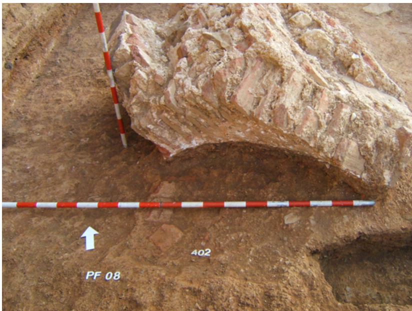
Lám. 25. Detalle de la bóveda del acceso desplomada.
