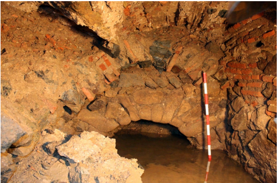
Lám. 15. Interior de la red principal de evacuación de aguas.
