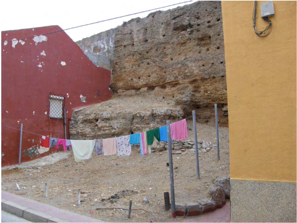
Lám. 22. Afrag. Viviendas adosadas.
