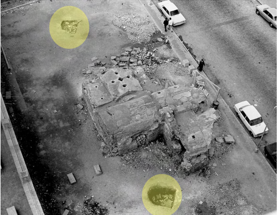
Lám. 6. Imagen del baño poco después de la demolición de las viviendas que lo ocultaba. En los círculos, la entrada de los dos aljibes señalados en el texto.
