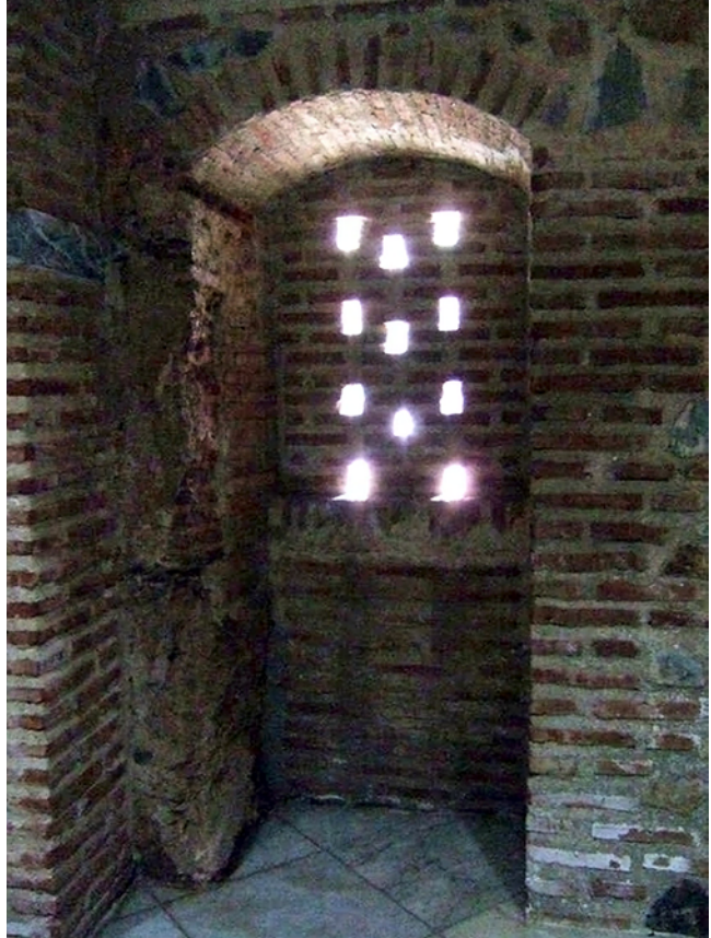
Lám. 3. Vano cegado en el muro occidental de la sala tibia.
