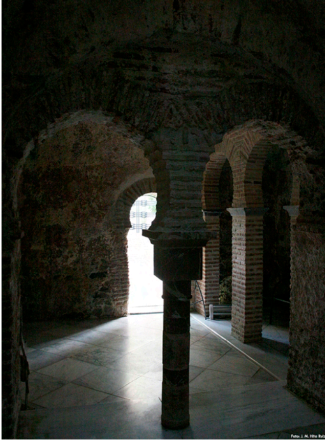
Lám. 2. Sala fría del baño tras su restauración.
