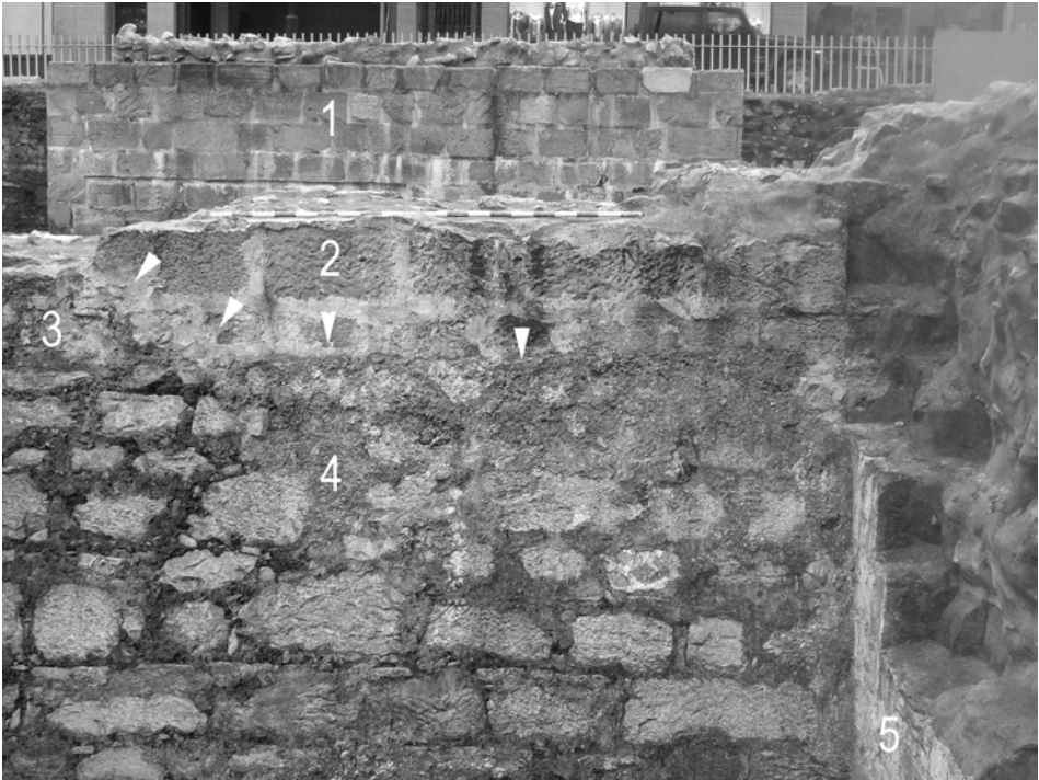
Lámina 3. Obras de sillería: torre (1), retazo de barbacana (2) y Puerta de Gibraltar (5). Fábricas de mampostería y sillarejo: barbacana (3) y escarpa del foso (4). Las flechas indican la interfaz entre la barbacana de sillería y la de mampostería.
