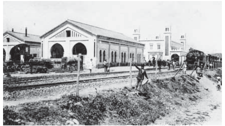
En primer término los hangares de la línea férrea. (Archivo: Paco Sánchez)
