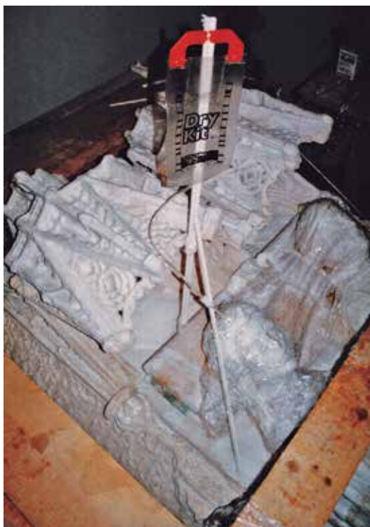
Intervenção de consolidação realizada a finais dos anos 90.
