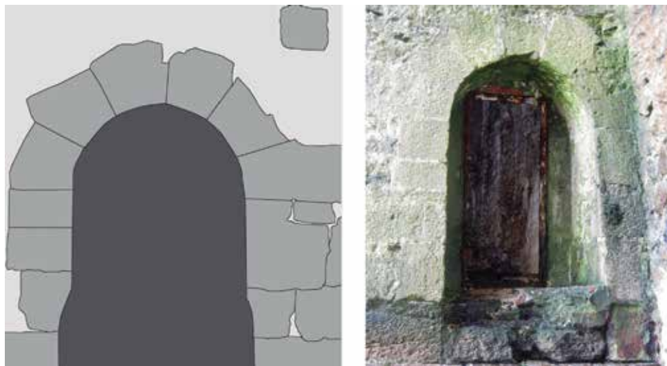
Fig. 28.- Izquierda, poterna norte. Derecha, poterna sur.
